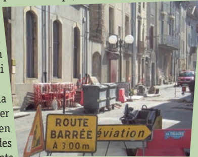
Les travaux dans la rue des Barris
