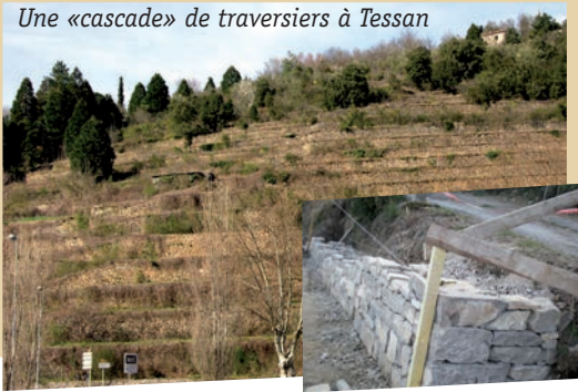
Une «cascade» de traversiers à Tessan
