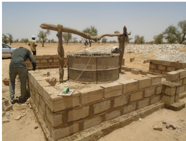
A gauche la construction de la margelle du puits de Ongo et à droite son aire d'assainissement.
