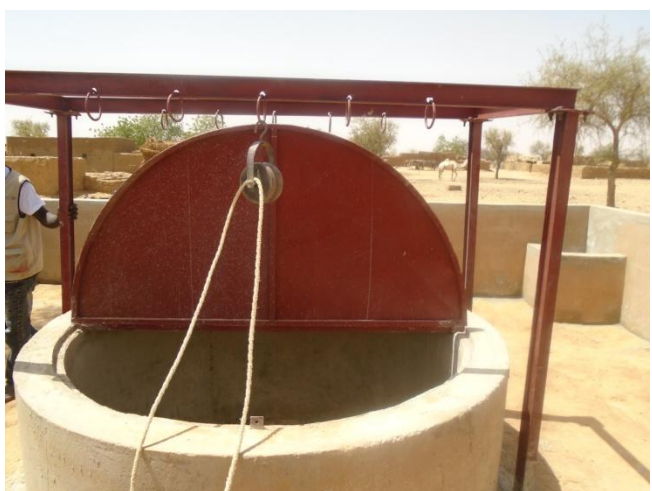
A gauche le couvercle du puits de Birga Dogon et son portique avec la poulie et les crochets. A droite le couvercle fermé : ainsi on garde l'eau propre.
