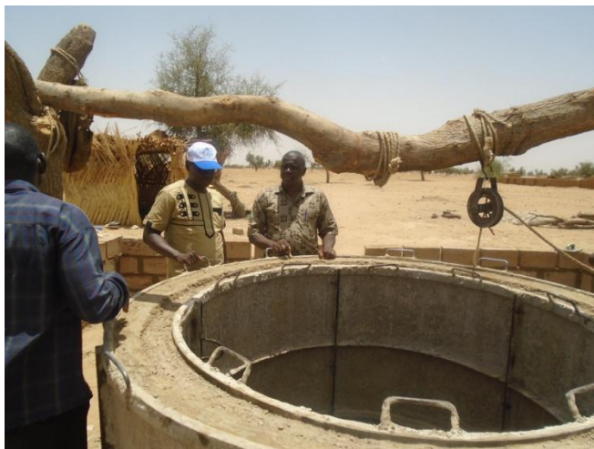
A gauche la construction de la margelle du puits de Ongo et à droite son aire d'assainissement.
