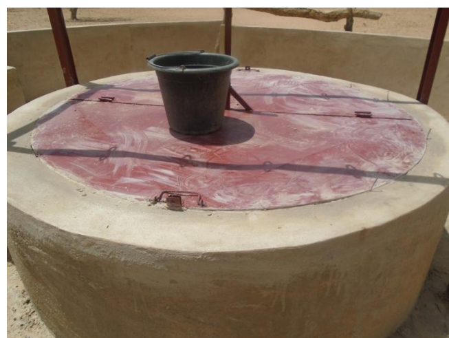
A gauche le couvercle du puits de Birga Dogon et son portique avec la poulie et les crochets. A droite le couvercle fermé : ainsi on garde l'eau propre.
