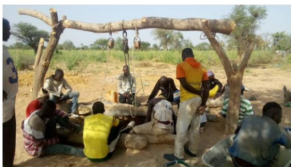
A gauche : les bénévoles du village autour du trou : ils vont remonter le sable et les roches dégagés à la pioche par les puisatiers, et pour la construction des buses ils vont chercher l'eau à 2 km du chantier. A droite : les maçons qui construisent les buses pour sécuriser le puits : un travail titanesque et dangereux !
