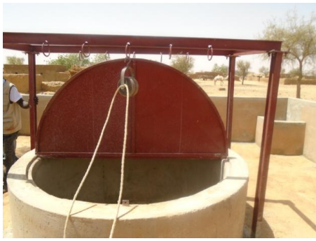
A gauche : le nouveau puits de Guindourou, avec son aire d'assainissement, son portique et sa clôture. A droite : la construction de l'abreuvoir à Birga Dogon.
