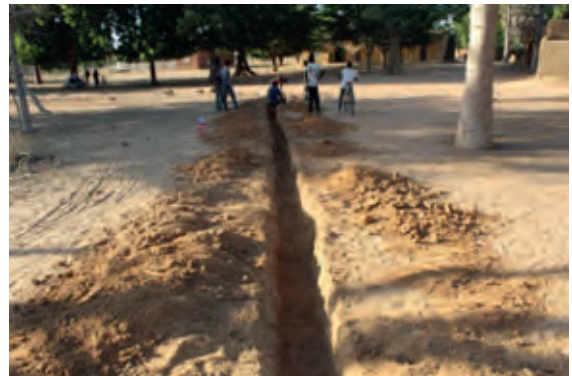
Ici la canalisation qui amènera l'eau de la borne fontaine aux latrines publiques du marché.
