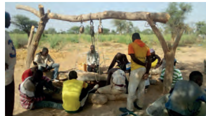
Les bénévoles du village autour du trou : ils vont remonter le sable et les roches dégagés à la pioche par les puisatiers, et pour la construction des buses ils vont chercher l'eau à 2 km du chantier.
