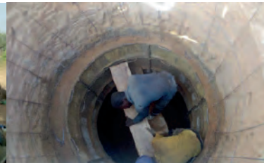
Les maçons qui construisent les buses pour sécuriser le puits : un travail titanesque et dangereux !
